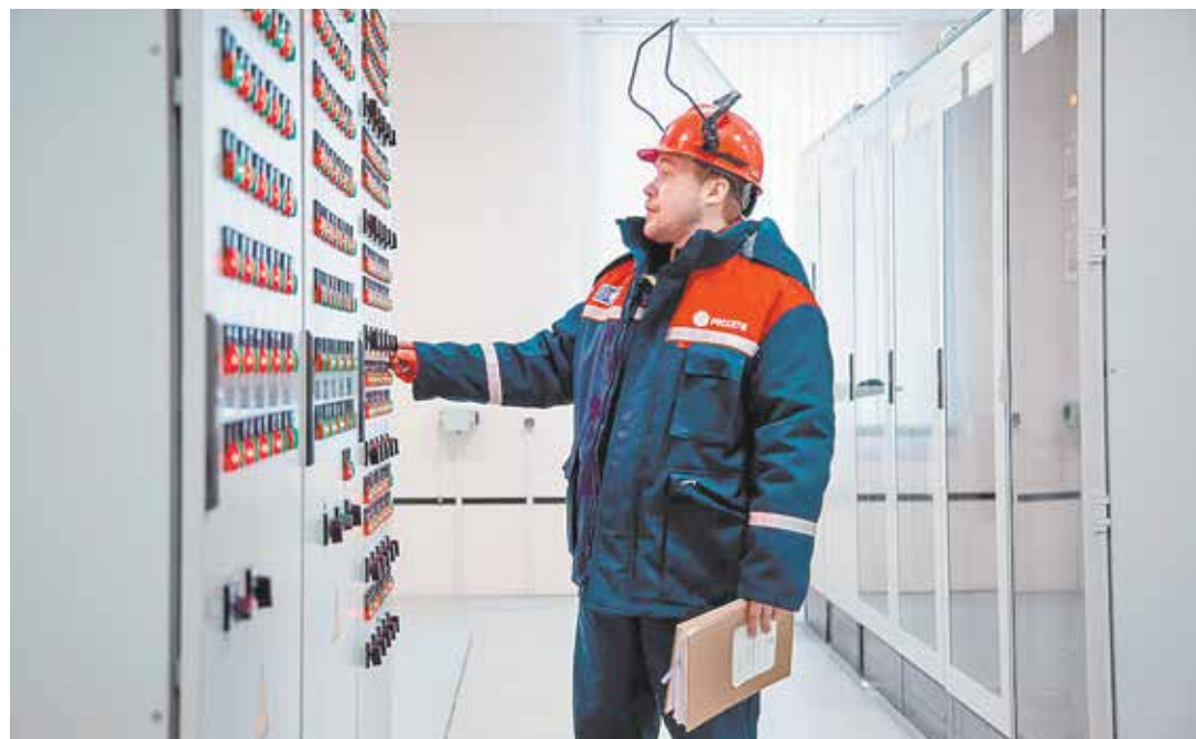
Новая электростанция «Белорусская»
