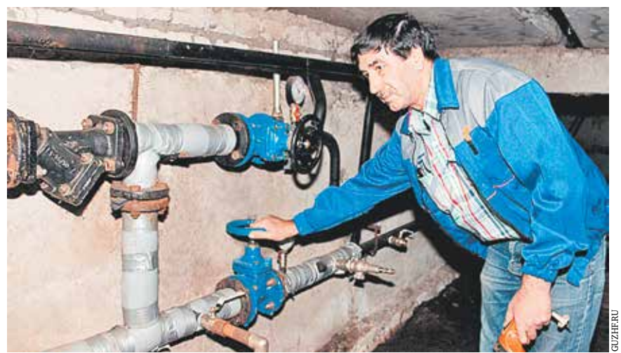
Во время подготовки многоквартирных домов к эксплуатации в осенне-зимний период 2017-2018 годов
