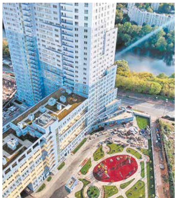
Самое высокое из строящихся в регионе жилых зданий — 26-этажный дом в ЖК «Утесов»
