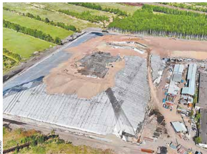
Работы по рекультивации полигона ТБО «Электросталь» в Московской области
