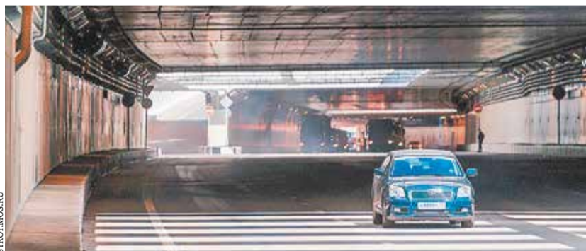
Совмещенный автомобильный и метротоннель на пересечении с Калужским шоссе
