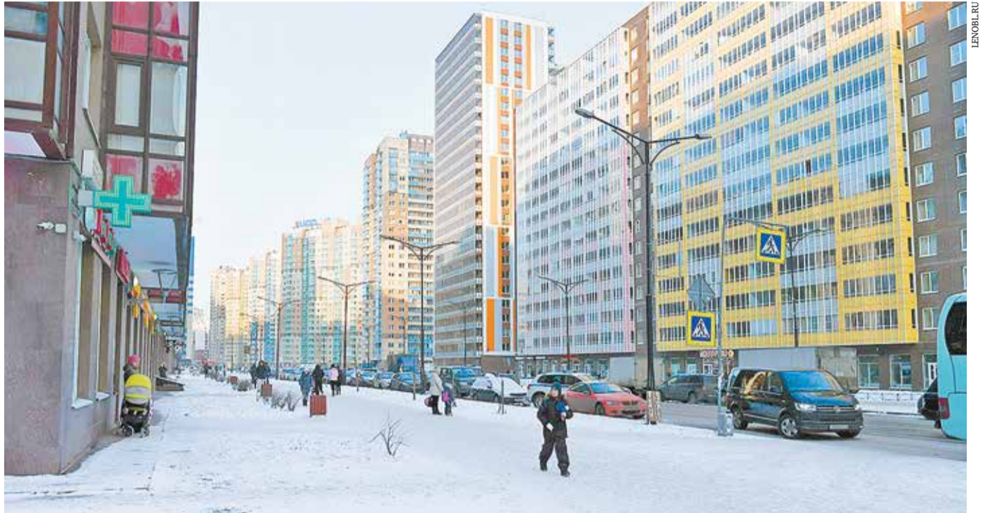
Жилая застройка на Европейском проспекте в Кудрово Всеволожского района
