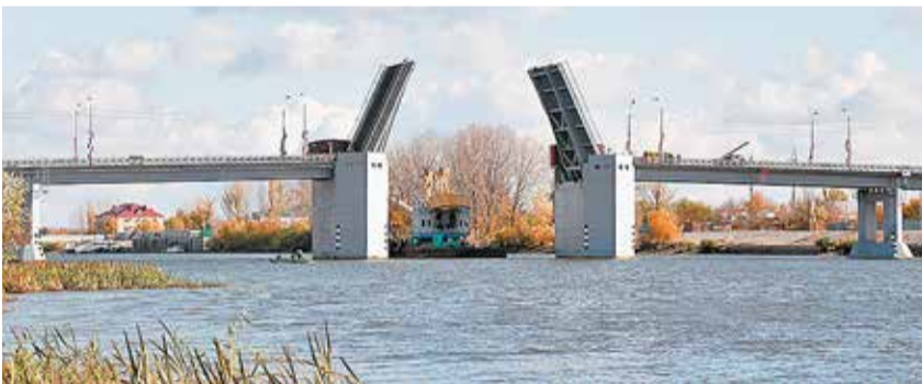
Кирикилинский мост через реку Кривую Болду в Астраханской области
