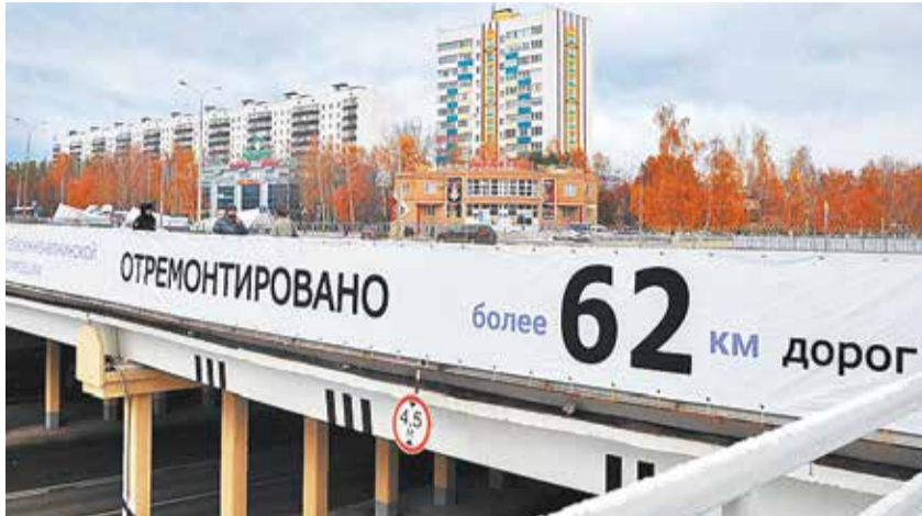
Завершены ремонтные работы на Московском проспекте в Набережных Челнах
