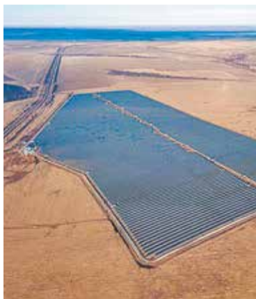
Сорочинская солнечная электростанция (СЭС «Уран»)
