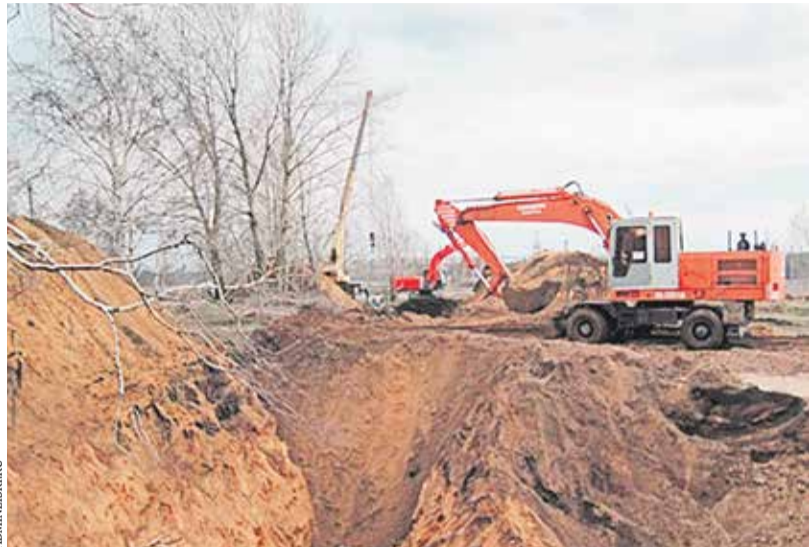
Реконструкция канализационного коллектора на полях фильтрации в городе Лиски
