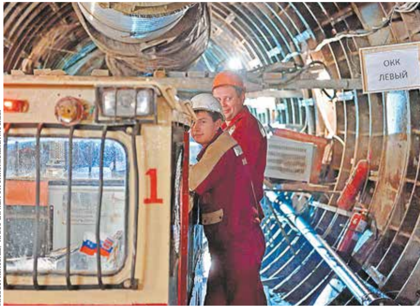
Строительство станции метро «Шереметьевская» в Москве
