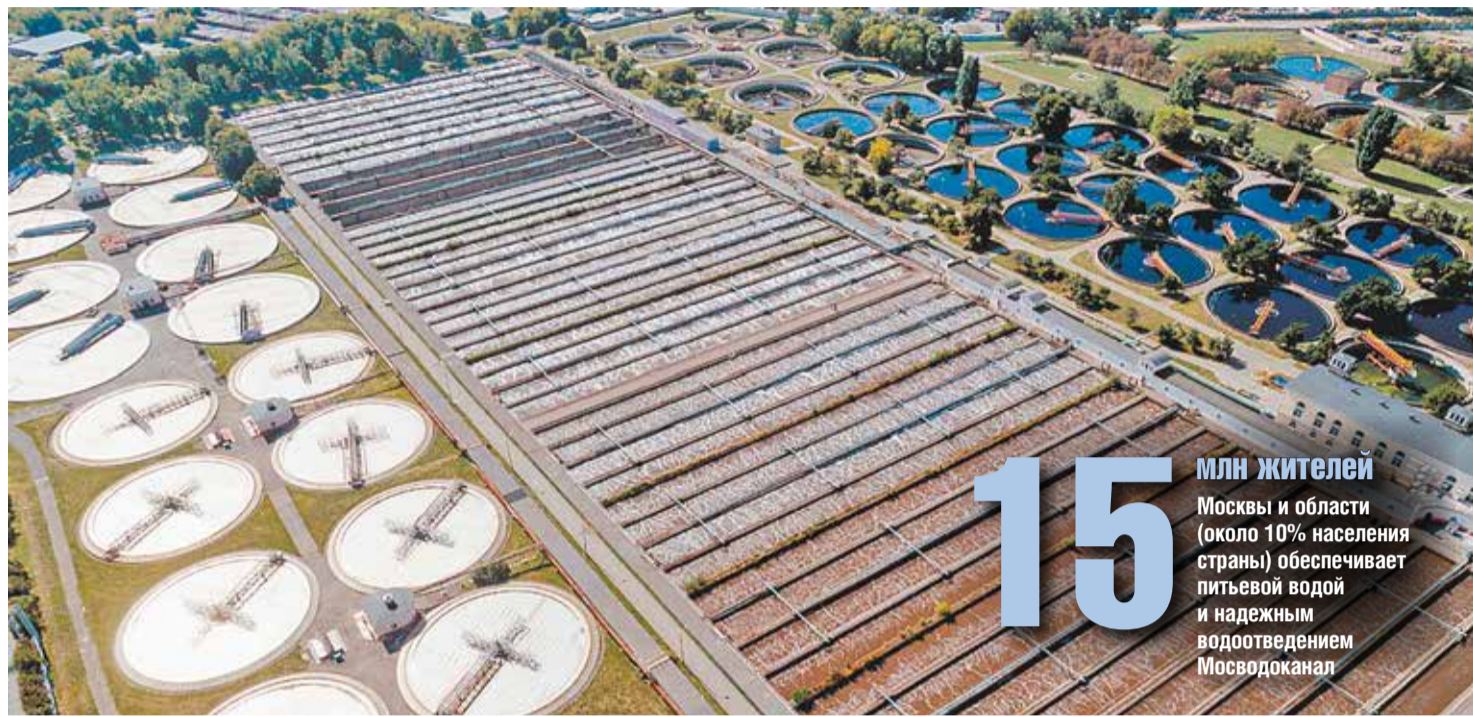
Люберецкие очистные сооружения
