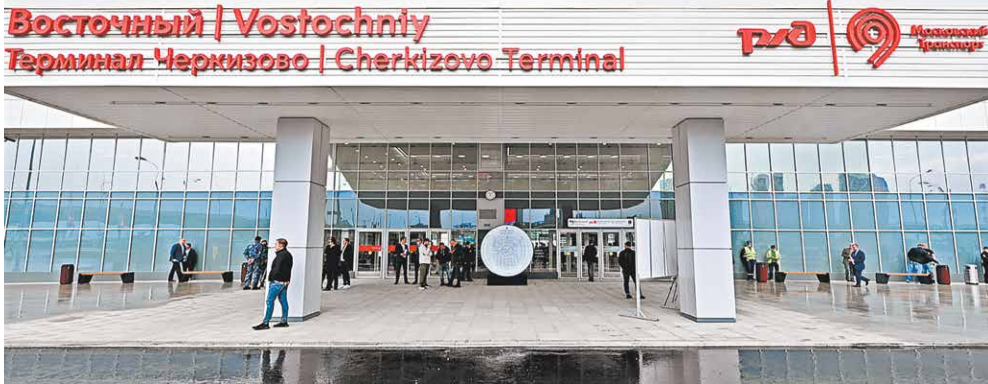
МИХАИЛ КОЛОБАЕВ / ПРЕСС-СЛУЖБА СТРОЙКОМПЛЕКСА МОСКВЫ
