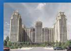
Дом «Нобель» ГК «Новый Мир» Новосибирская область
