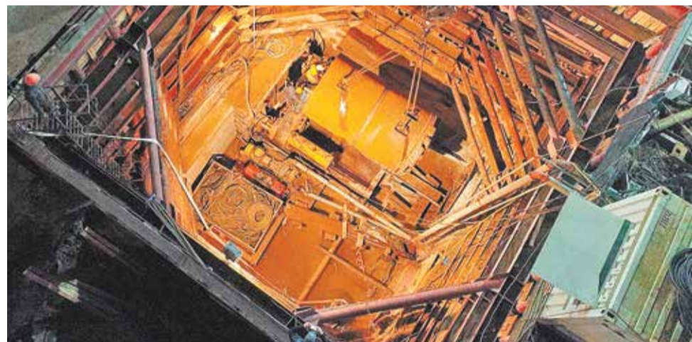
Работы по прокладке тоннелей под ТТК велись ночью, чтобы не мешать движению транспорта
