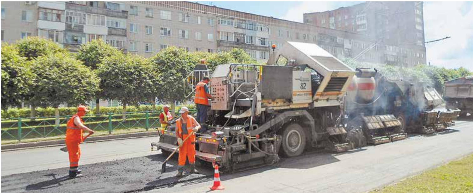
Дорожно-ремонтные работы в Чебоксарах по программе «Безопасные и качественные дороги»
