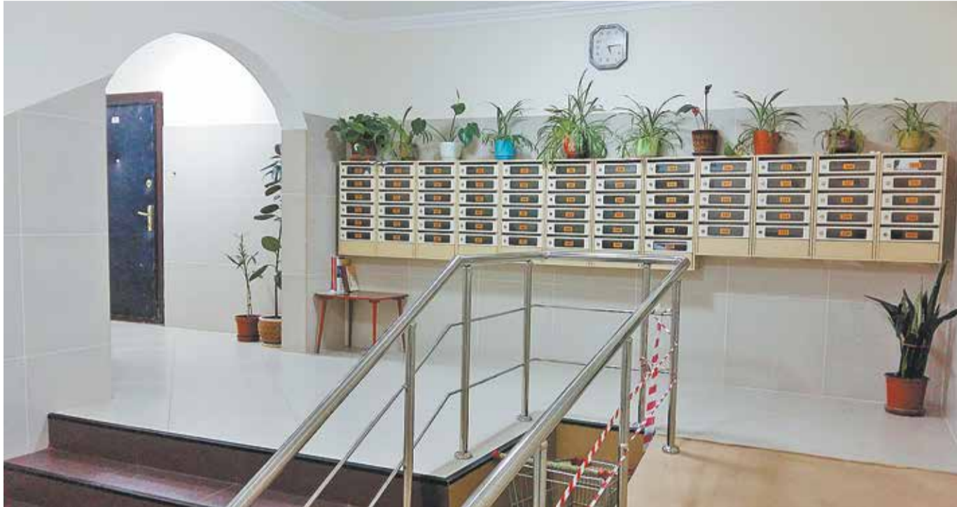
Отремонтированный подъезд дома на улице Стадионной в Королеве. На выходе из тамбура здесь установлена стеклянная автоматическая дверь
