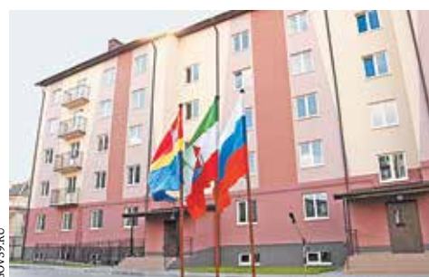
Советск стал первым муниципальным образованием в регионе, где начали переселение граждан из аварийного жилья
