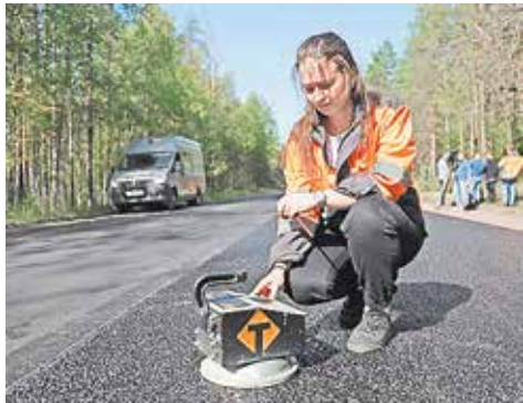
Проверка укладки верхнего слоя покрытия на участке дублера трассы «Скандинавия»
