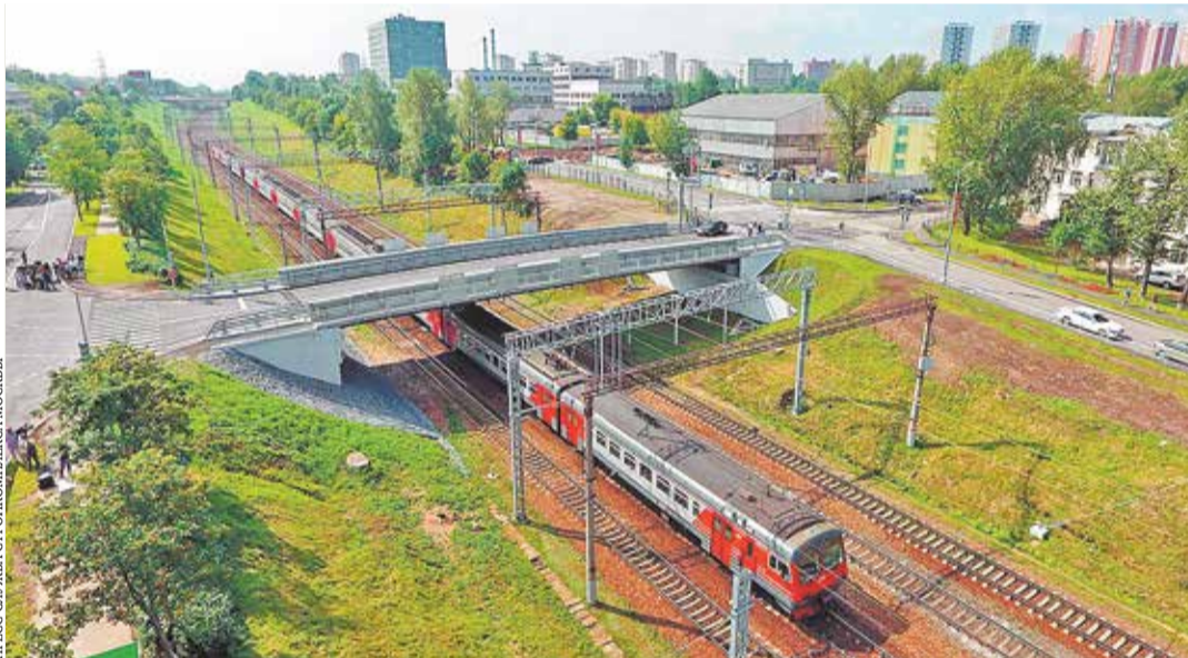
Путепровод через Павелецкое направление МЖД в районе Электролитного проезда
