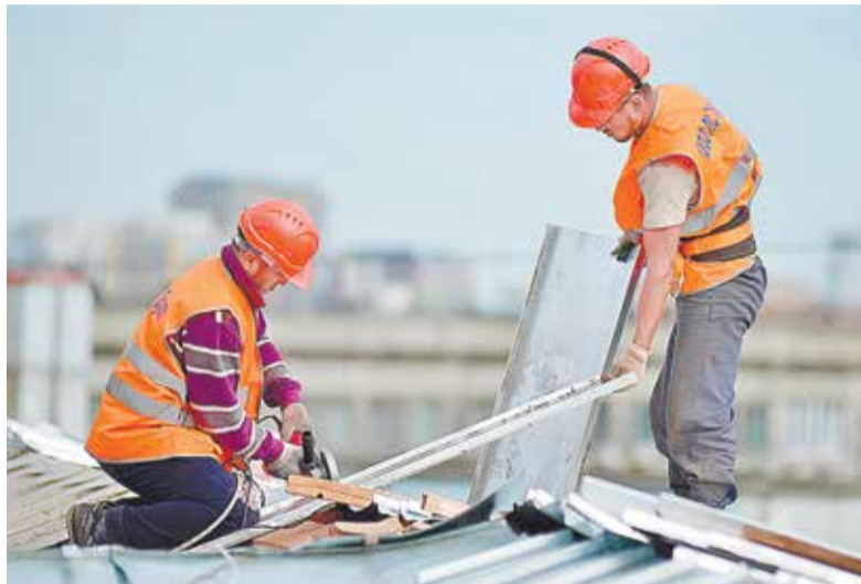
Ремонт кровли многоквартирного дома в Москве
