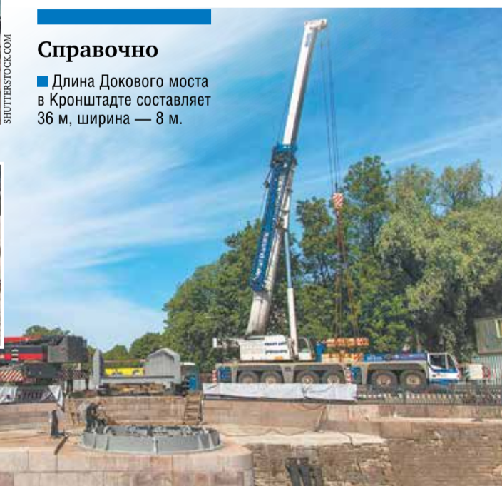
Отремонтированный мост установили на место с помощью двух подъемных кранов.
