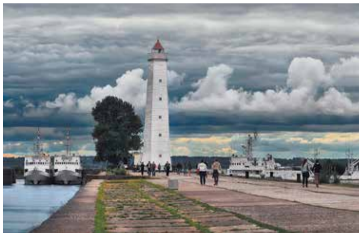
Пирс Петровского канала
