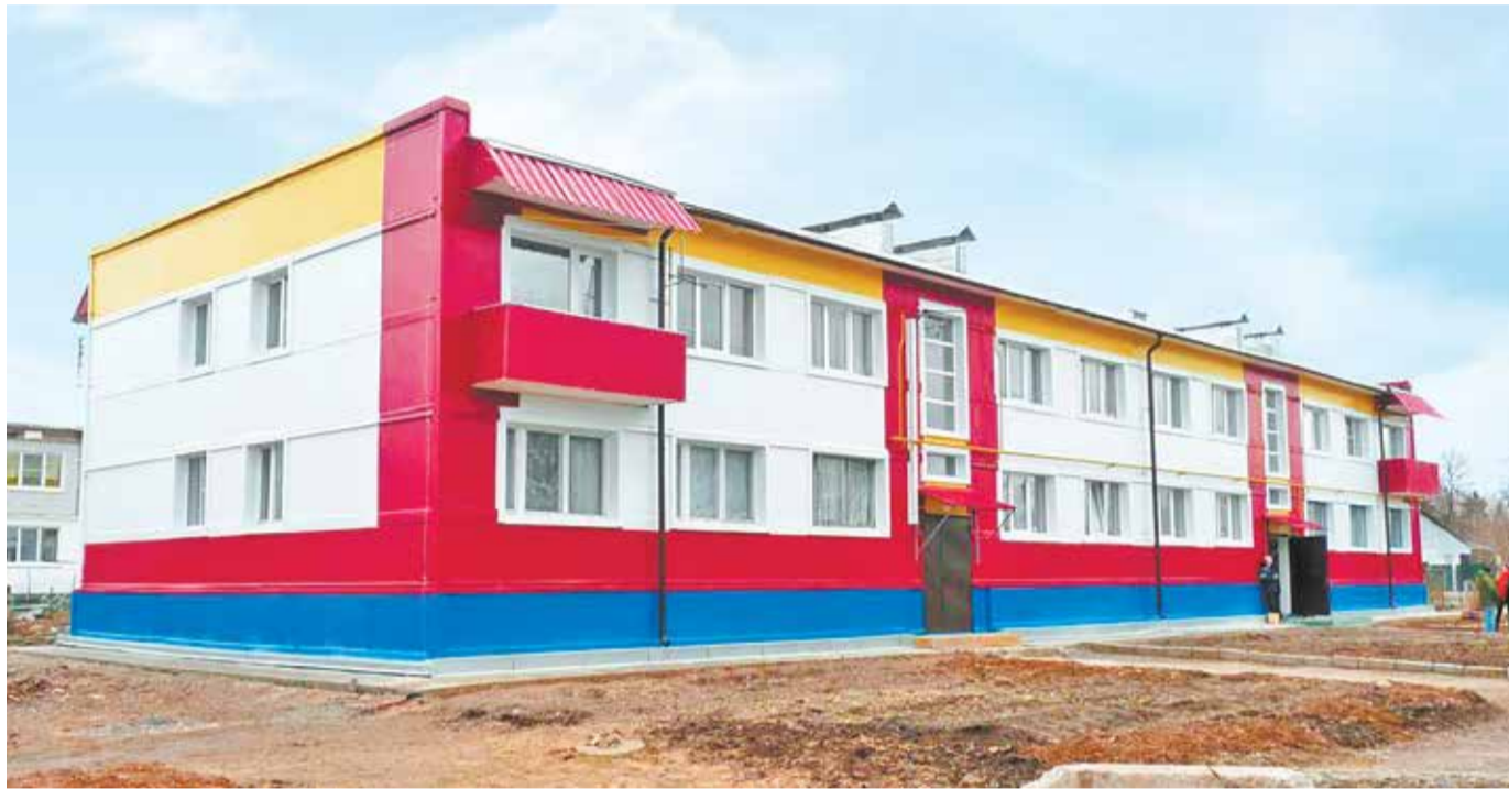
Отремонтированный с использованием нанотехнологий дом в Калужской области
