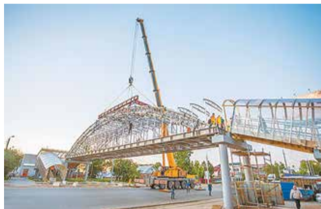
Возведение алюминиевого моста в деревне Афонино Нижегородской области
