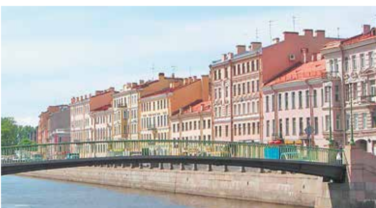
Коломенский пешеходный мост через канал Грибоедова в Санкт-Петербурге
