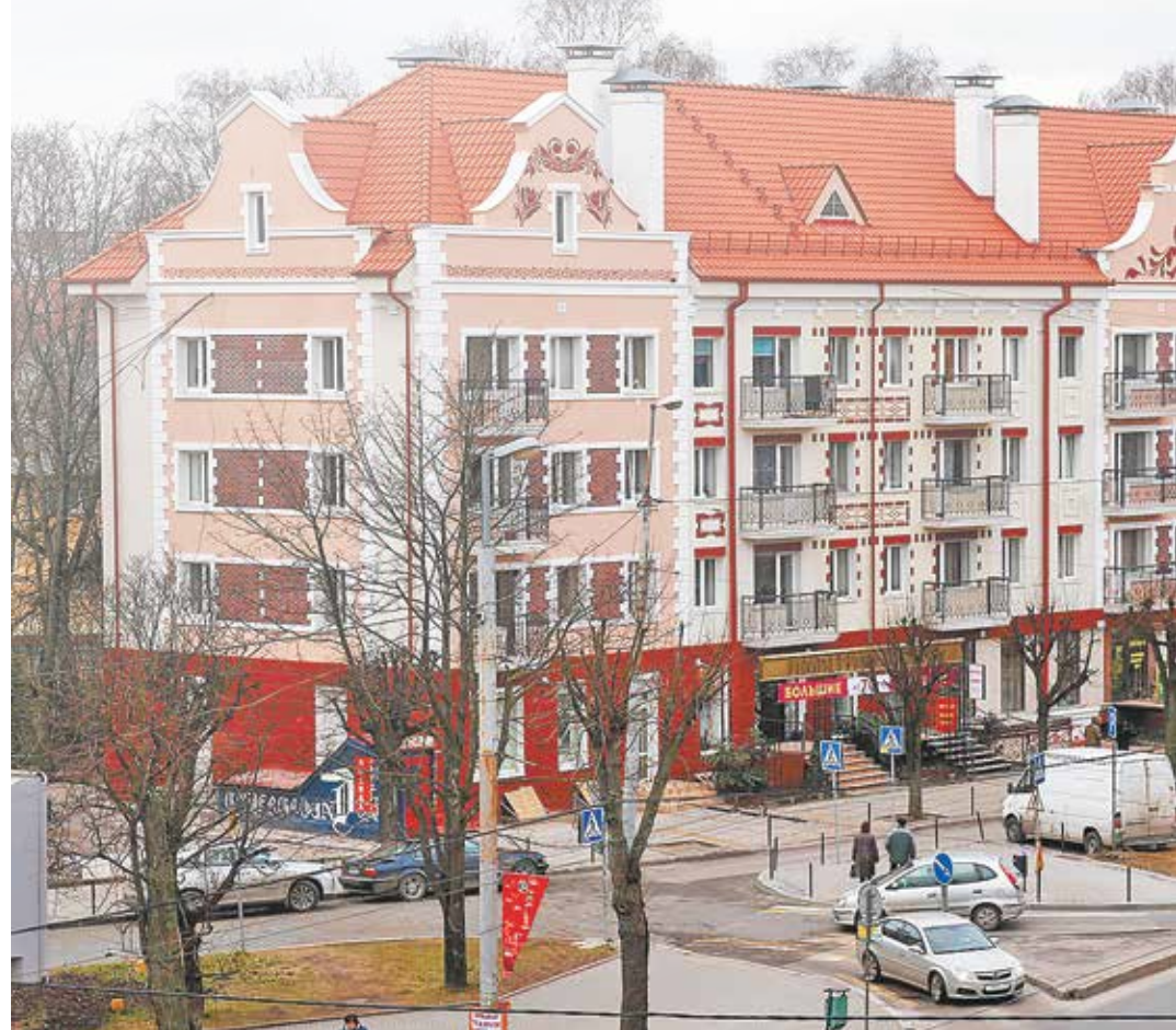
Дом на Ленинградском проспекте в Калининграде после ремонта фасада
