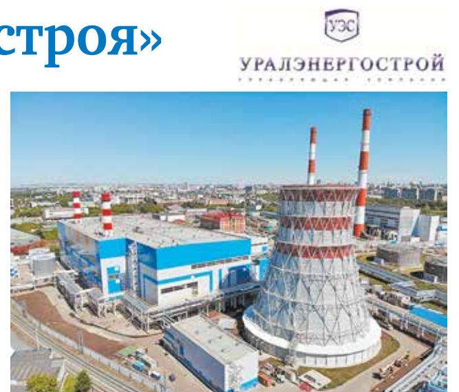
Общий вид филиала АО «Татэнерго» Казанская ТЭЦ-1
