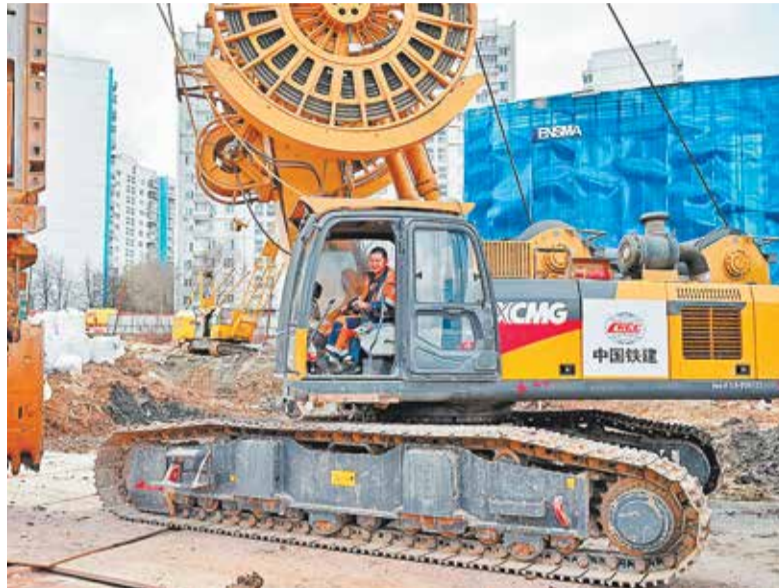
Китайский концерн CRCC участвует в строительстве станции метро «Мичуринский проспект» в Москве
