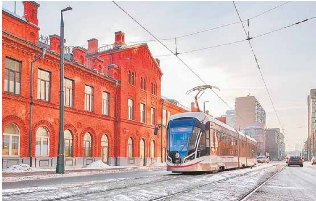
Миусское трамвайное депо на Лесной улице после реставрации
