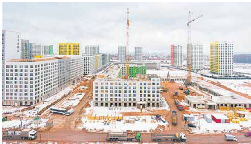
Строительство ЖК «Бунинские луга» (Москва)
