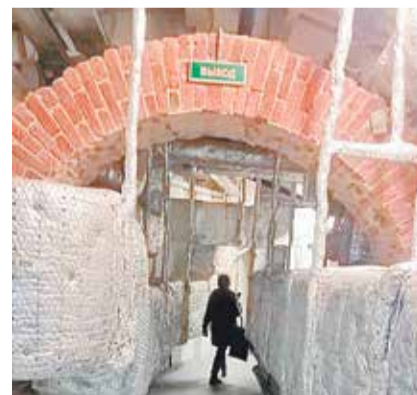
В котельной музея
