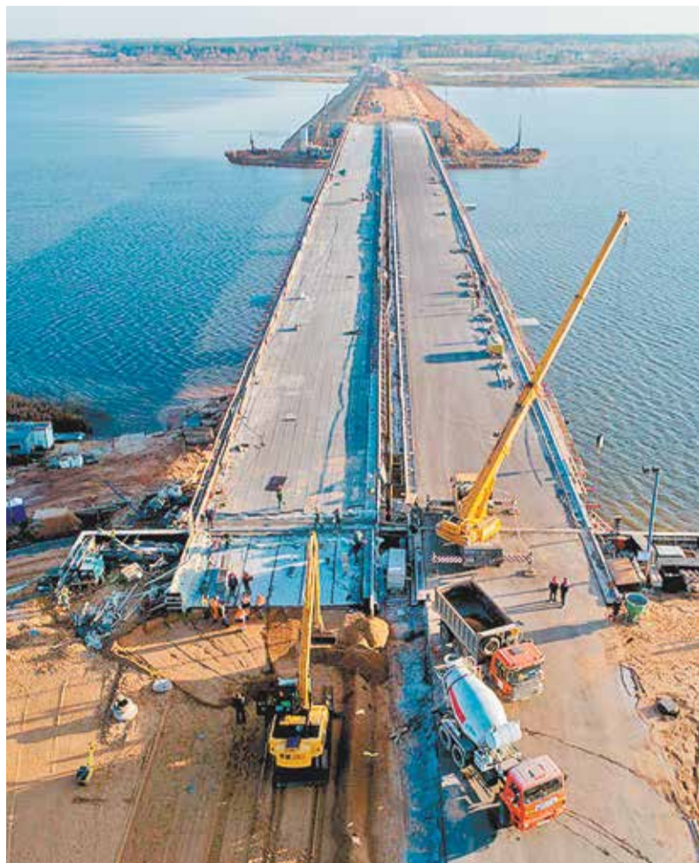
На строительстве моста через реку Шоша
