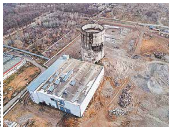
Воронежская атомная станция теплоснабжения после выполнения двух этапов демонтажа
