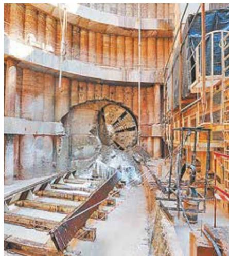
Выход тоннелепроходческого комплекса в монтажно-щитовую камеру у станции «Рижская» (БКЛ)
