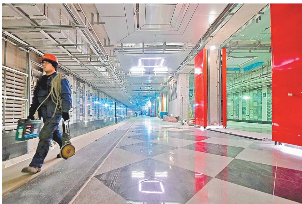
На строительстве станции метро «Рассказовка»
