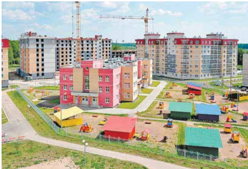
Строительство микрорайона «Пихтовый» в Среднеуральске
