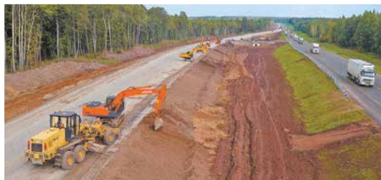
На строительстве трассы М-7 «Волга»
