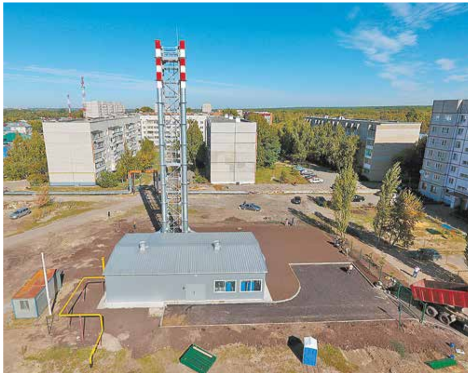
Новая блочно-модульная котельная в городе Котовске Тамбовской области
