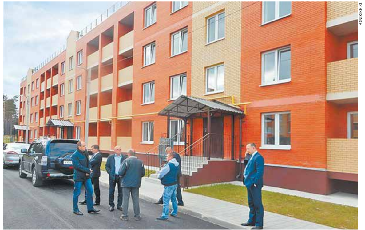
Члены рабочей группы Фонда ЖКХ проводят осмотр многоквартирного дома в городе Людиново (Калужская область)
