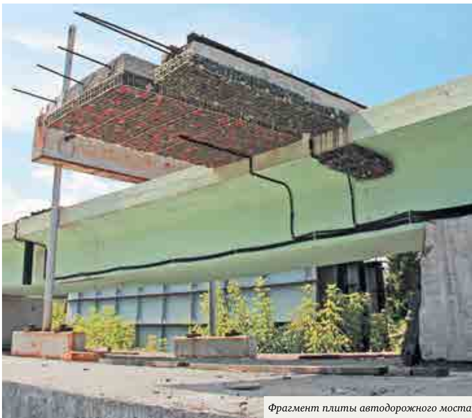
Фрагмент плиты автодорожного моста
