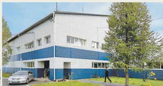
Водоочистные сооружения в Тобольске
