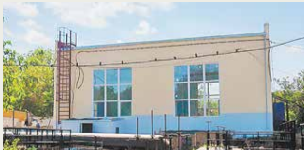
Насосная станция в Новошахтинске
