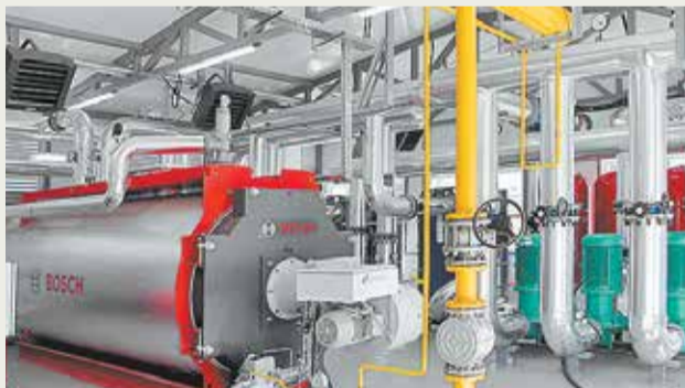
Блочно-модульная котельная в Котовске
