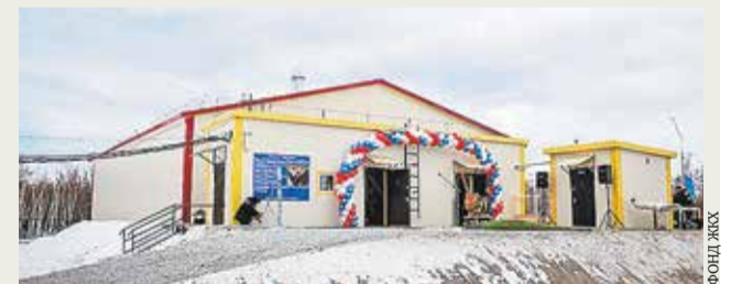
Очистные сооружения в селе Чурапча
