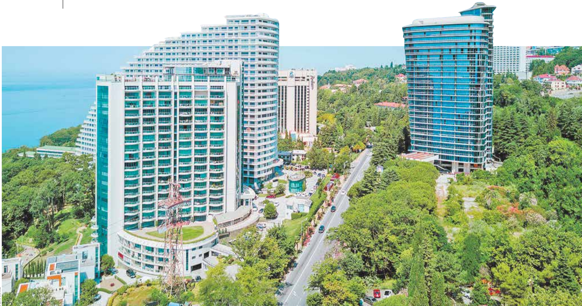
27-этажный многоквартирный дом в ЖК «Сан-Сити» (Сочи) — одно из самых высоких зданий, возводимых в Краснодарском крае (на фото справа)
