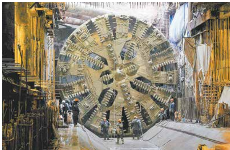
Проходческий щит «Надежда»
