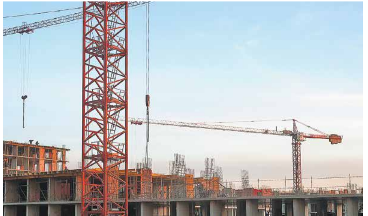
На строительстве ЖК «Москвичка» в Новой Москве
