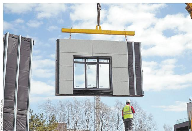
Модульный фасад TOPWALL состоит из силового каркаса с теплоизоляционным слоем, ограждающей конструкции из легкого бетона и облицовки и представляет собой наружный навесной несущий элемент стенового модульной сборки. После изготовления на заводе он транспортируется на стройплощадку и устанавливается в проектное положение с помощью кранштейнов крепления. Монтировать такие модули можно в любое время года. Работы по монтажу одного элемента выполняются всего за полчаса бригадой из четырех человек.
