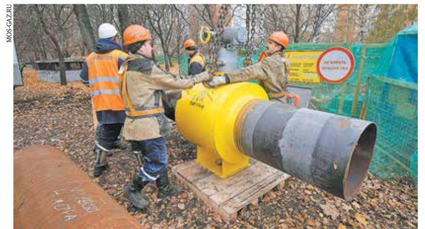
Установка автоматического запорного устройства с дистанционным управлением
