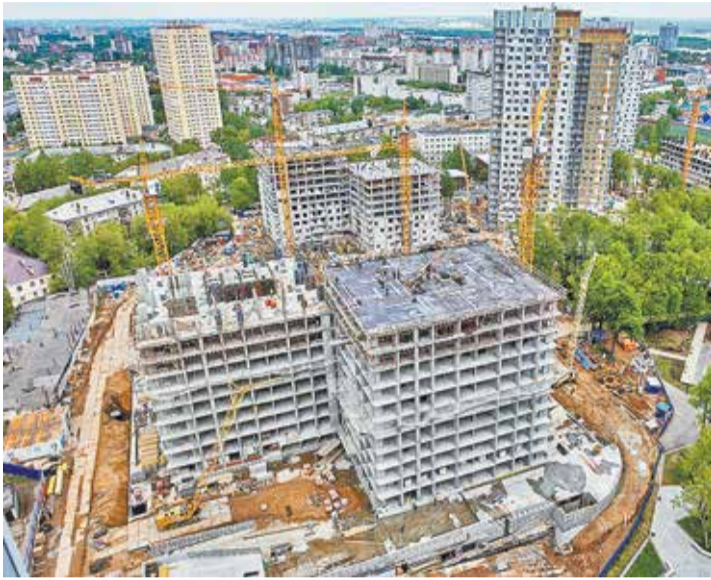
Строительство жилого дома Headliner в Перми
