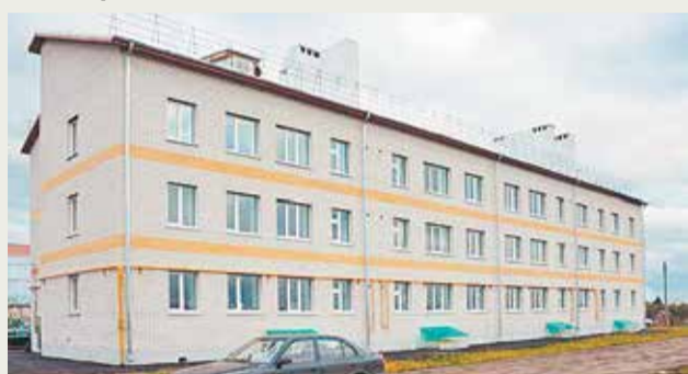
Дом в деревне Бебьево Нижегородской области, построенный в рамках региональной программы расселения «аварийки»
