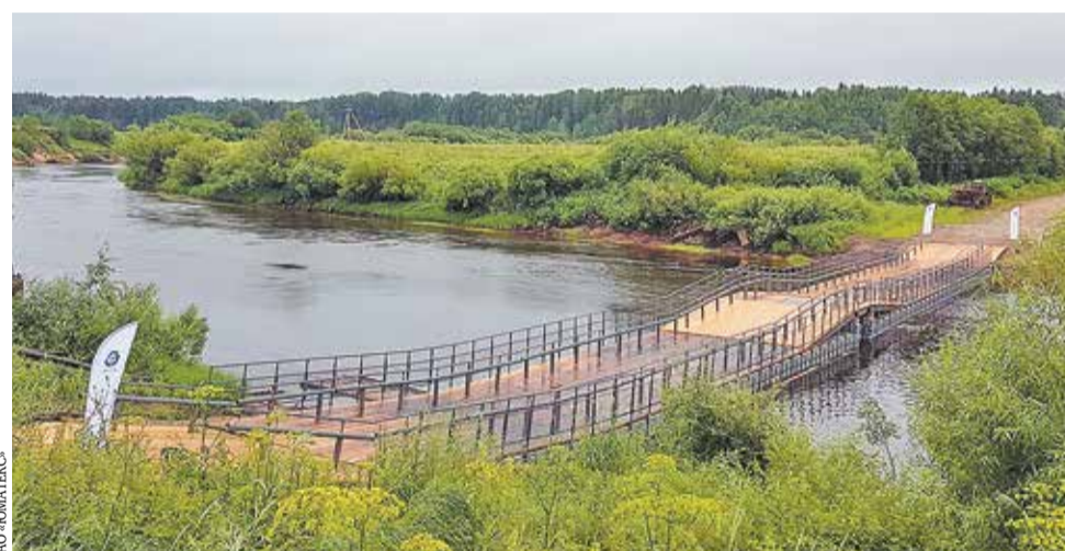
Наплавной (понтонный) мост через реку Емца в Архангельской области
