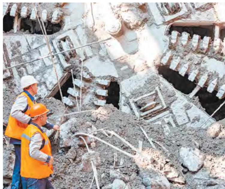
Завершение проходки тоннеля между станциями «Авиамоторная» и «Нижегородская»
