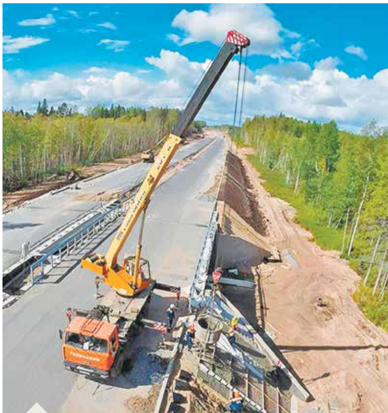
На одном из участков строительства трассы М-11
