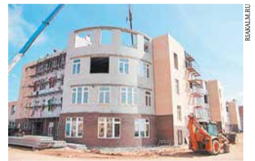
На строительстве здания школы в 9-м микрорайоне Элисты
