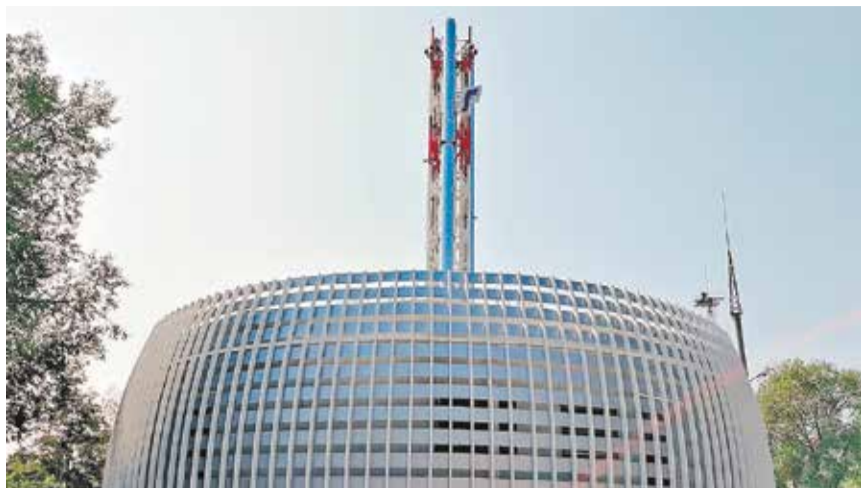
Котельная на улице Заводской в Белой Калитве
