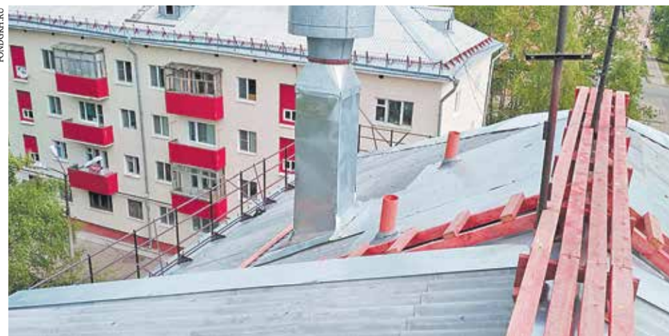
Крыша многоквартирного дома в городе Новодвинске после капитального ремонта
