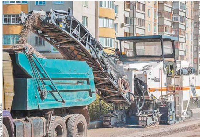
Холодный ресайклинг выгоден по многим параметрам. Технология экологична благодаря практически стопроцентной переработке и использованию «износившейся» прежней дорожной одежды, отсутствию отходов и расхода ГСМ для подвоза новых материалов. Качество стабилизированного слоя отвечает самым высоким требованиям, а цикл строительных работ намного короче. В целом, по критериям «стоимость-эффективность-время» у холодного ресайклинга практически нет альтернативы.
