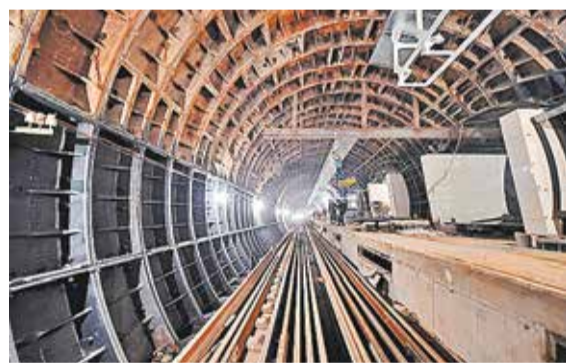
На строительстве станции «Савеловская»
