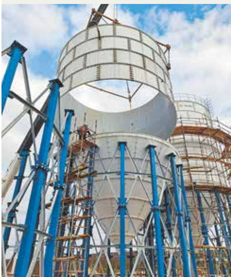
Монтаж силоса цемента 1 300 тонн
