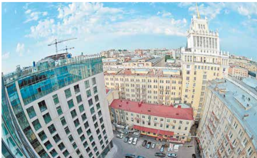
Во время строительства элитного квартала «Сады Пекина» в районе Триумфальной площади
