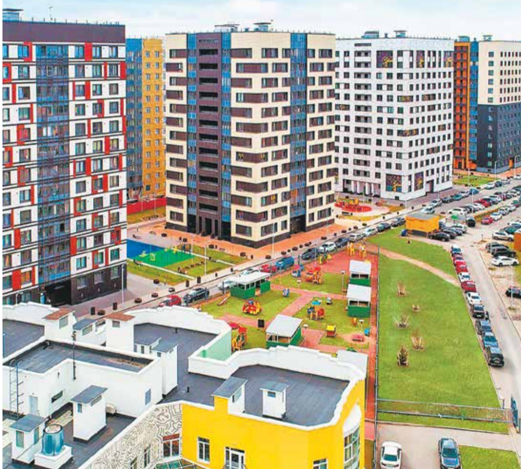
В рамках VI Санкт-Петербургского культурного форума проводилась экскурсия с посещением территории ЖК «Европа Сити», представленного как новый формат жилой массовой застройки
