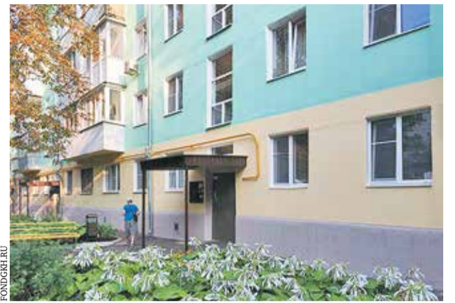
Ремонт фасада дома №145/2 по улице Таганрогской в Ростове-на-Дону
