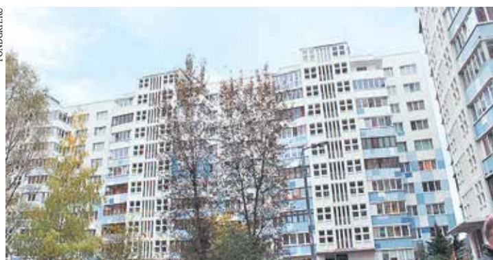
В доме на набережной Генерала Карбышева, 8 (Калининград), проведен энергоэффективный ремонт
