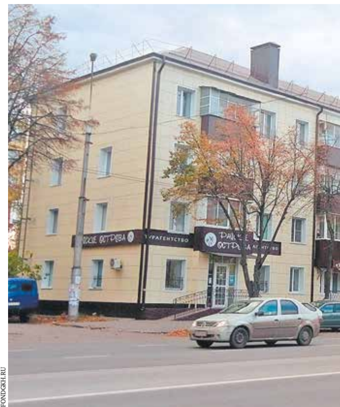
Дома №29 и 31 по улице Гагарина в Липецке после проведения капитального ремонта
