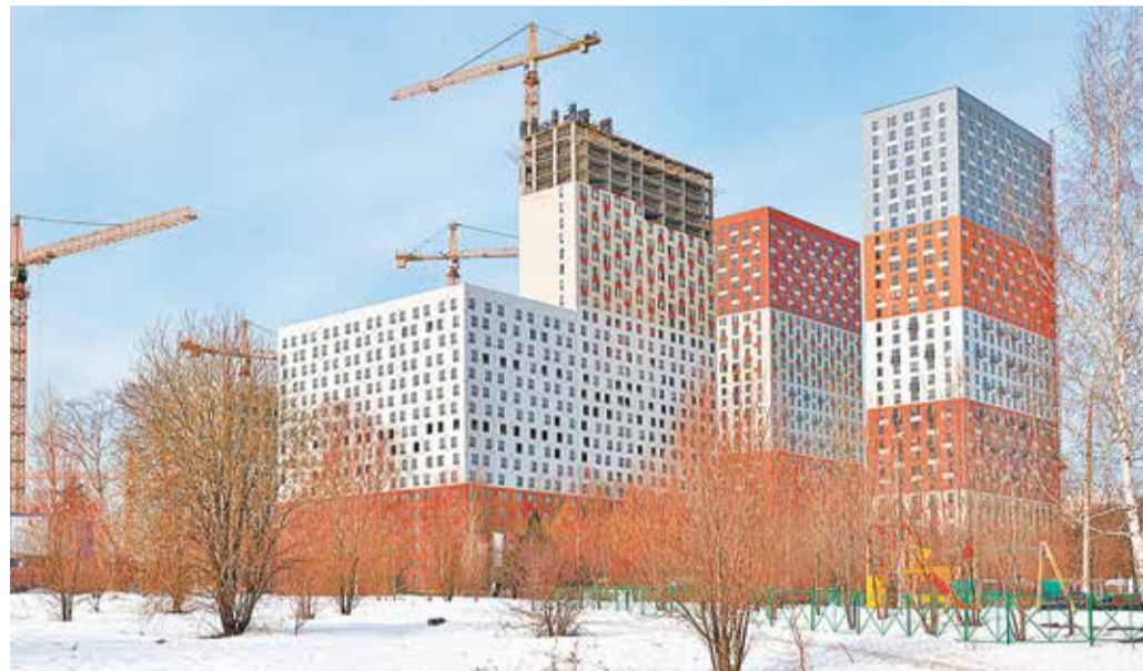
Строительство жилого комплекса «Митино Парк» в Москве
