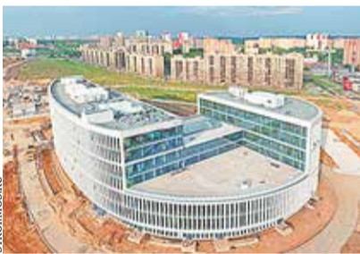
Здание в АДЦ «Коммунарка», где разместилась префектура ТиНАО
