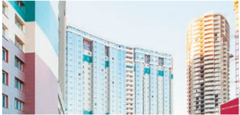
Самым высоким строящимся зданием Северной столицы является 32-этажный дом в ЖК «Петр Великий и Екатерина Великая»
