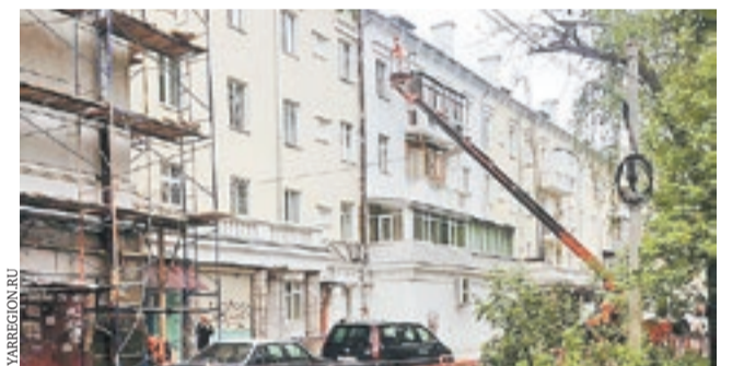
Капитальный ремонт в жилом доме №11 на проспекте Ленина в Ярославле
