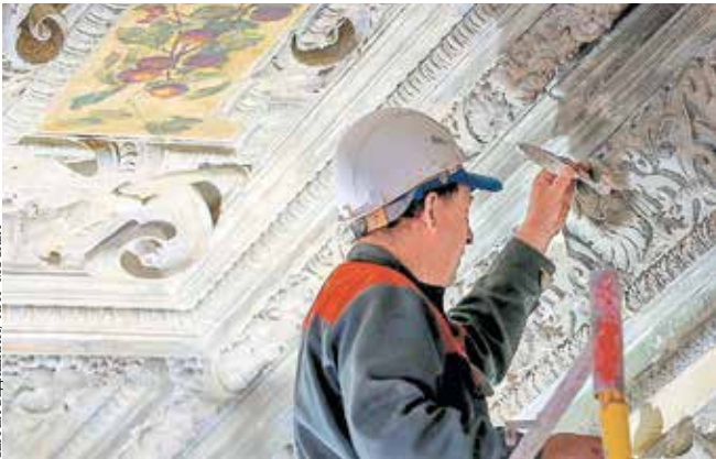
СТРОИТЕЛЬ РАБОТАЕТ НА РИМОНОВСКОМ ЗАМКЕ
