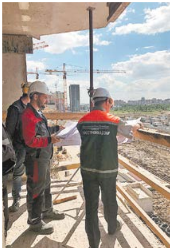
Работники Госстройнадзора проверяют один из строящихся объектов в Санкт-Петербурге
