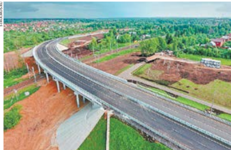
Путепровод в Кокоскино
