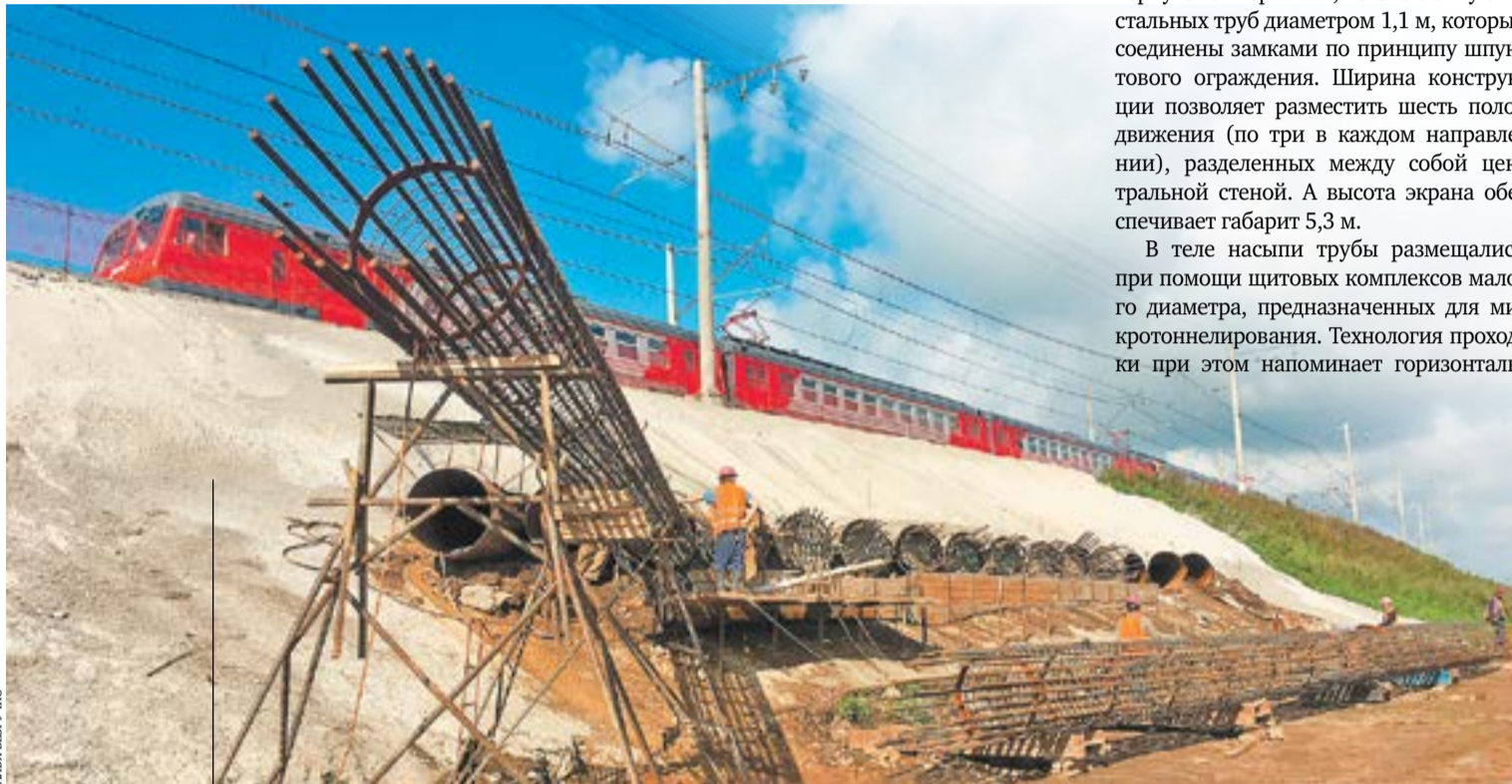
Устройство защитного экрана на строительстве тоннеля
