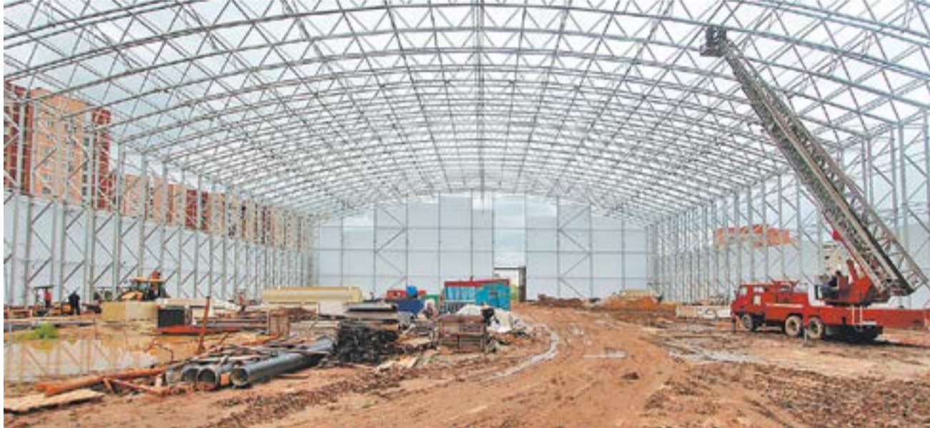
Строительство крытой футбольной арены «Олимп» на улице Суздальской в Новокосино
