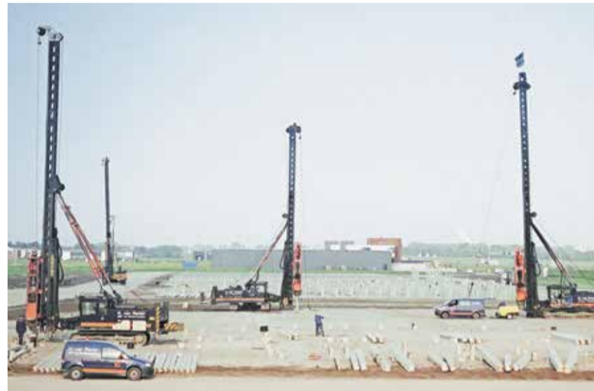
Гидравлическая сваебойная техника за работой
