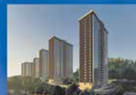
ЖК «Восточный ЛУЧ» ООО «СЗ «Восточный ЛУЧ» Приморский край
