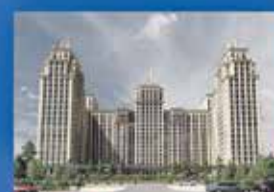
Дом «Нобель» ГК «Новый Мир» Новосибирская область
