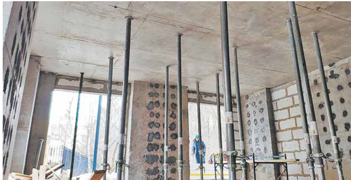
Поврежденные огнем плиты и пилоны в строящемся доме по улице Павлова в Москве до и после усиления железобетонными обоймами
