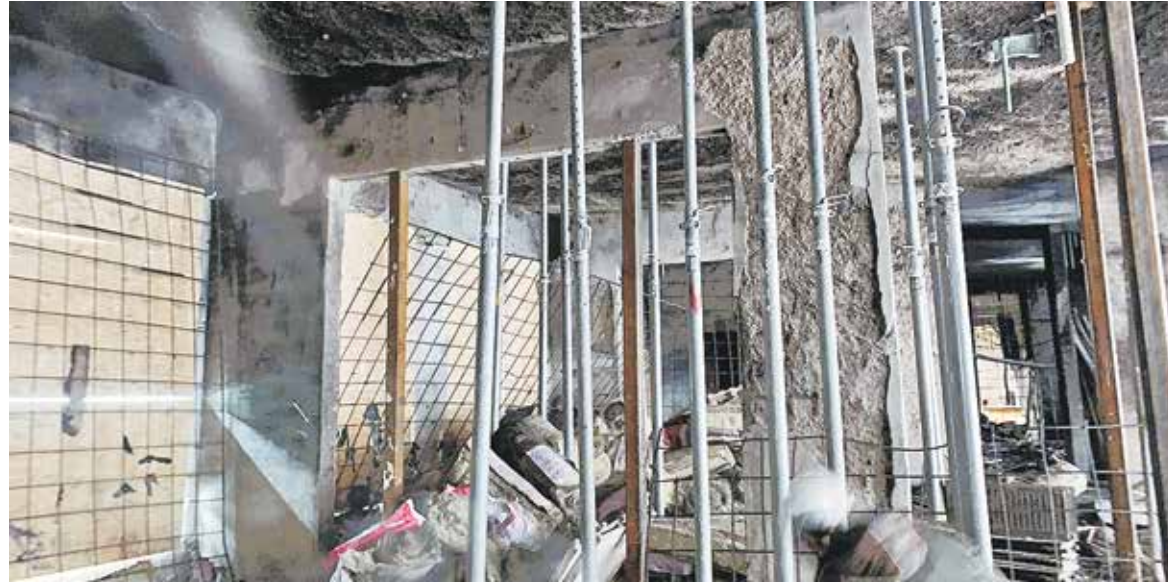
Поврежденные огнем плиты и пилоны в строящемся доме по улице Павлова в Москве до и после усиления железобетонными обоймами
