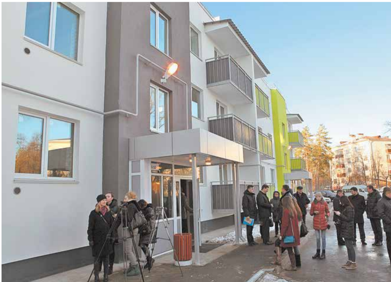
В таких трехэтажных домах будут жить специалисты Института атомных реакторов
