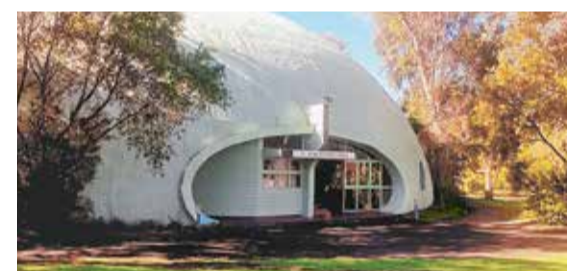
Здание Fairvale High School, построенное с помощью технологии «бинишелл»
