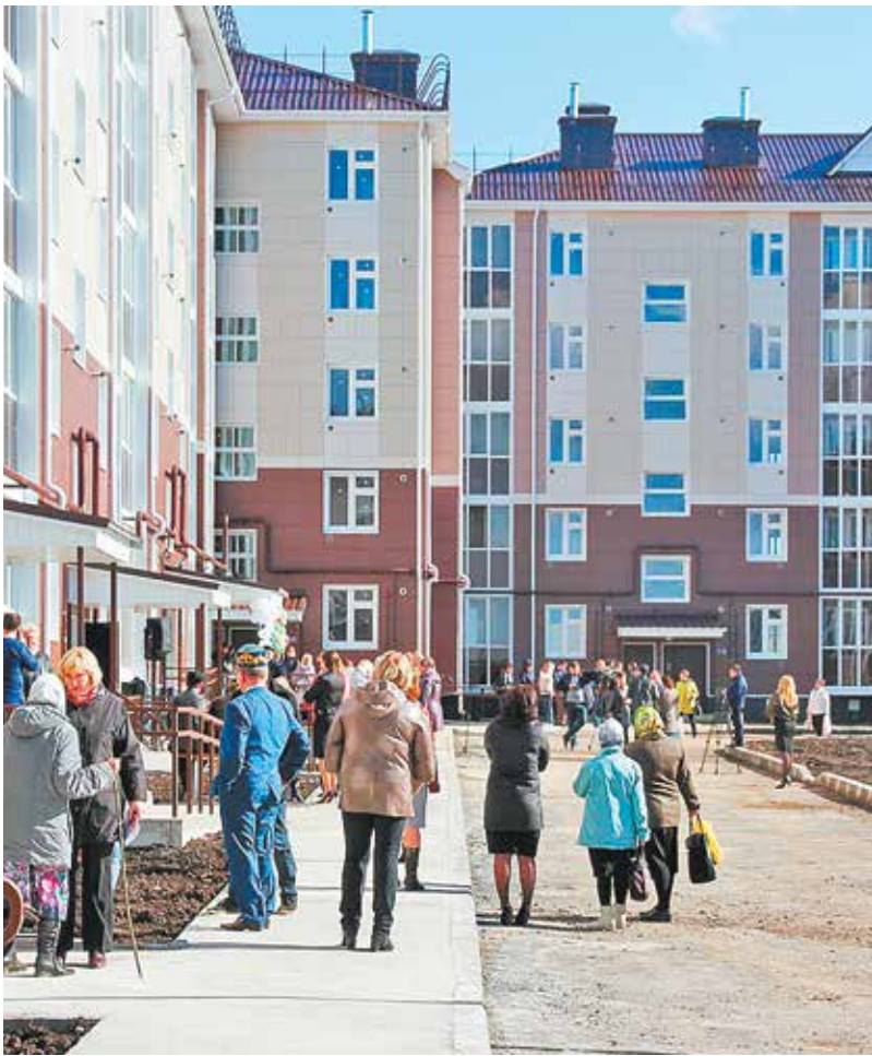
Переселенцы из аварийного жилья получили ключи от новых квартир в доме на улице Полющенкова в Чистополе
