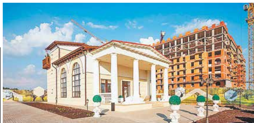
Строительство ЖК «Видный город»
